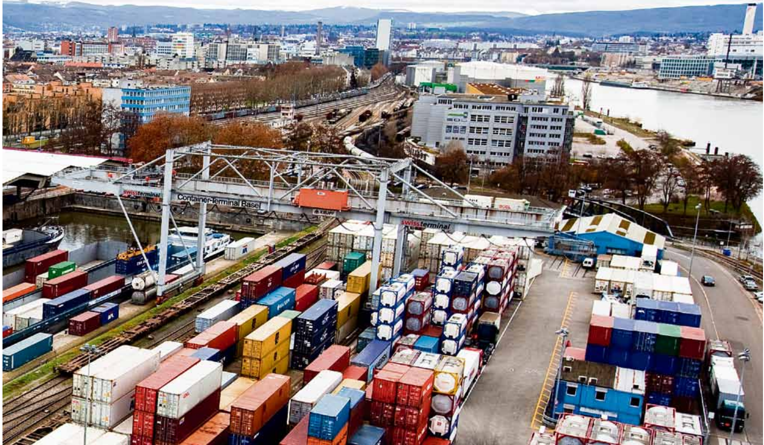
Vor dem Aufbruch: Der Kleinhüninger Hafen wird in den nächsten Jahren erweitert und neu angelegt. Damit wird in Basel Nord scheinbar Unmögliches möglich.
