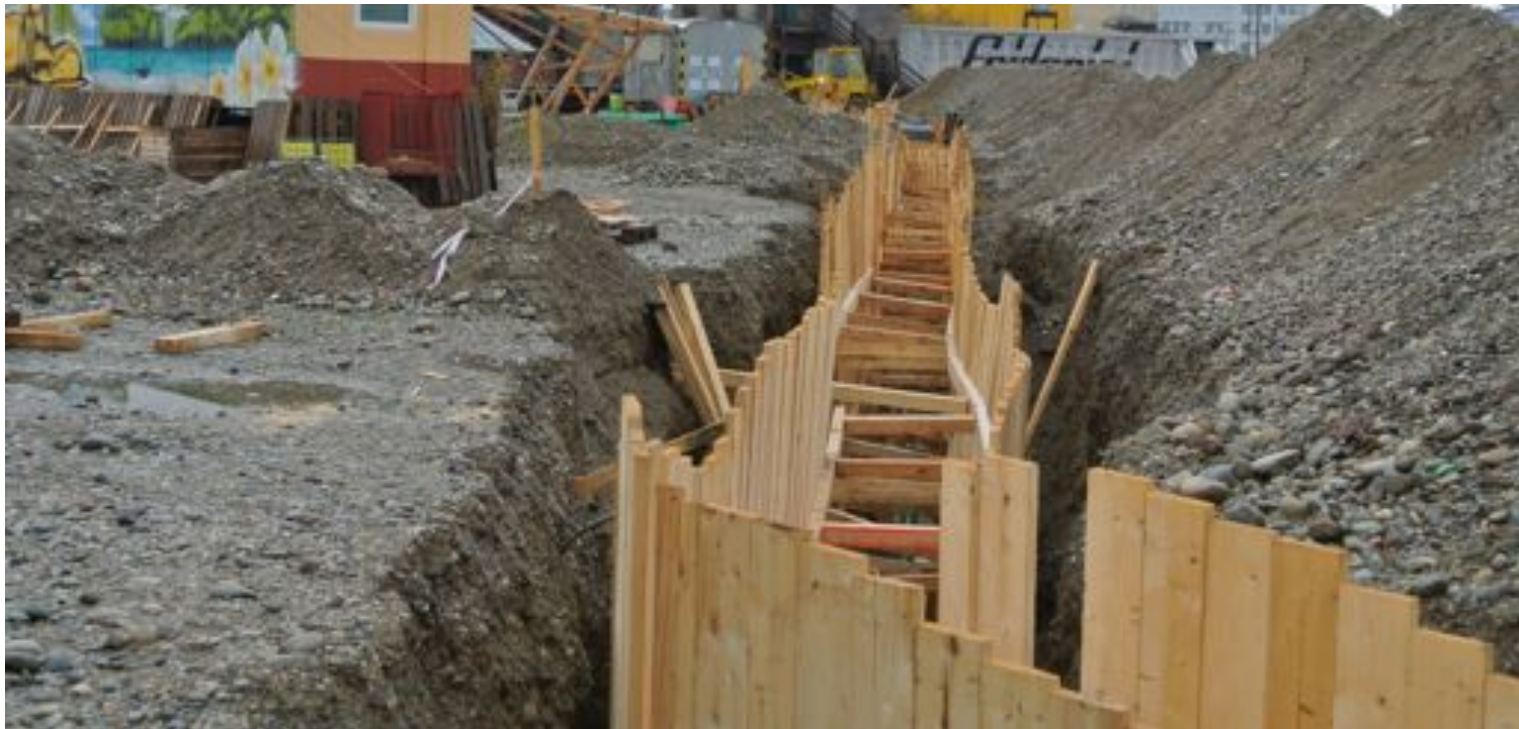
Die Betreiber verlegen ihre eigene Kanalisation. (Bild: Dominique Spirgi)
