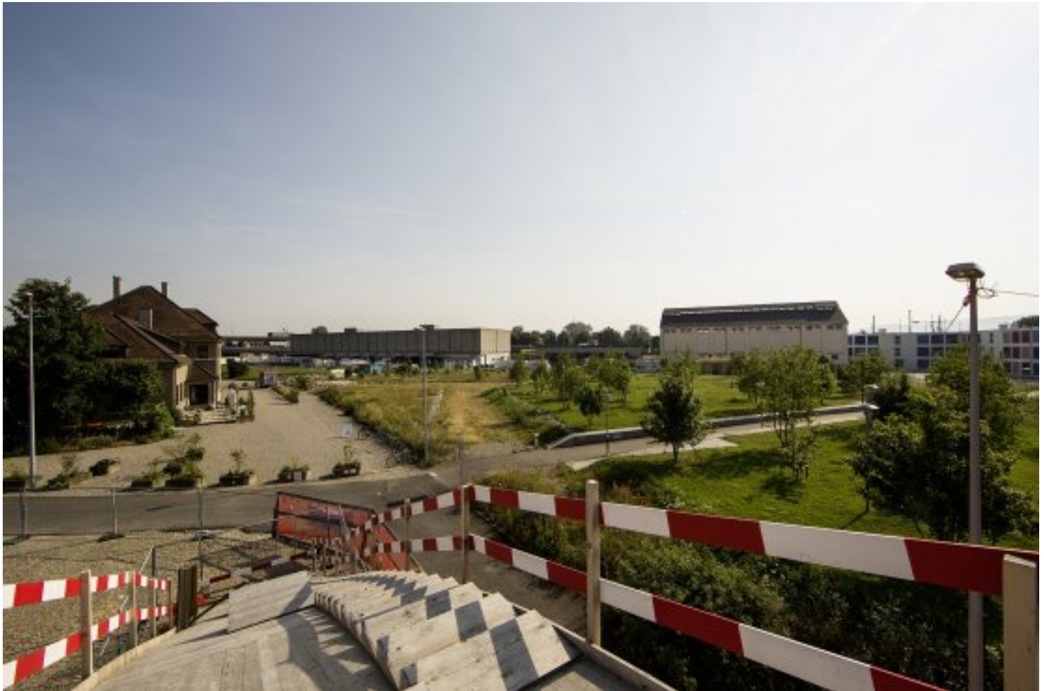
Erlenmatt West: Die Baufelder rücken den letzten Kulturbetrieben auf dem Areal immer näher. (Bild: Nils Fisch)
