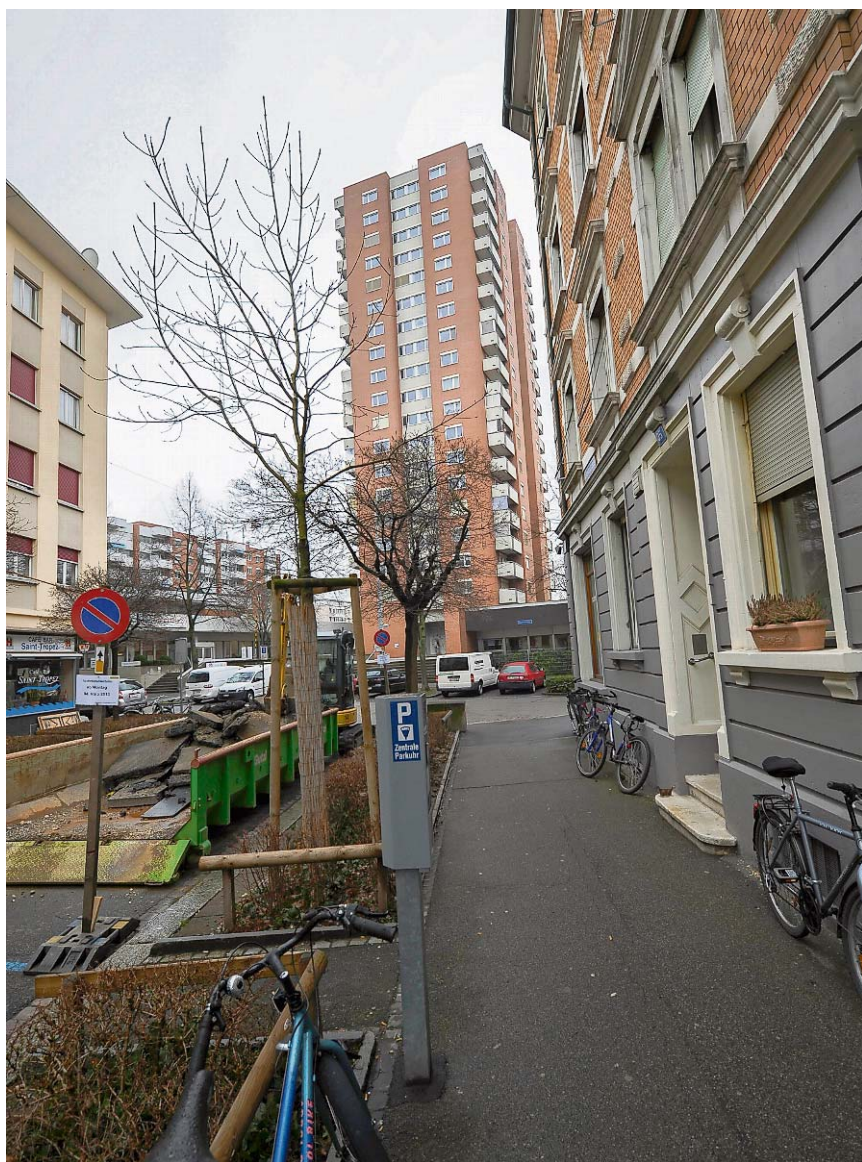
Funktionierendes Beispiel für einen Wohnturm: Sperrstrasse 40. TÖNGI
