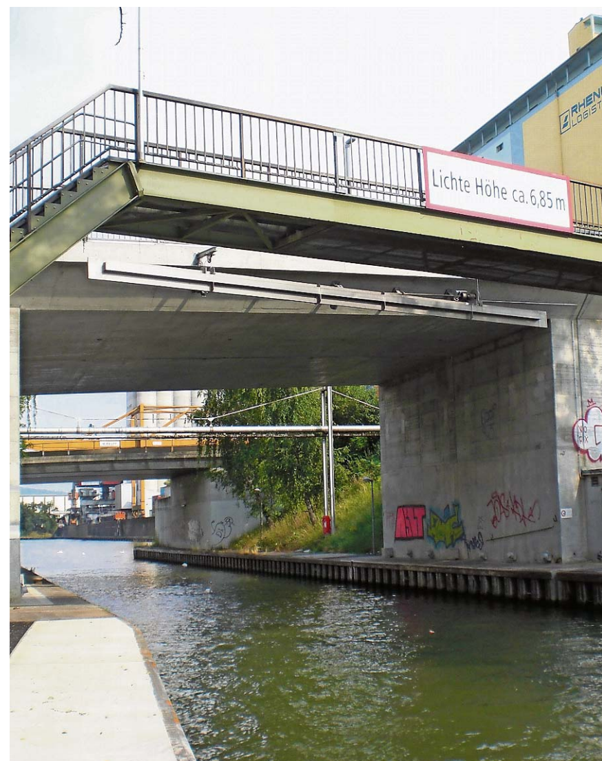
Die Einfahrt ins Hafenbecken 2 ist mit drei Lagen Containern nur mit Ballastwasser risikolos möglich. Die hintere Brücke kann aber in Zukunft um 50 Zentimeter angehoben werden.
