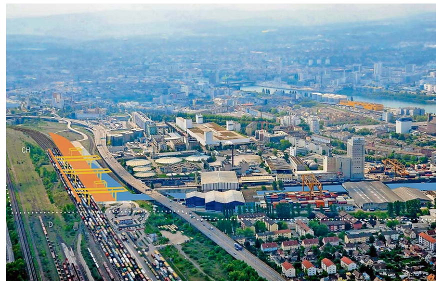
Künftig sollen durch das Brücken-Nadelöhr nicht nur die Terminals in Hafenbecken 2 (quer durchs Bild), sondern auch der Terminal Basel Nord im geplanten Hafenbecken 3 (links) erreichbar sein. ZVG
